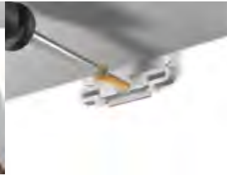
Mise en place de la fixation murale B
